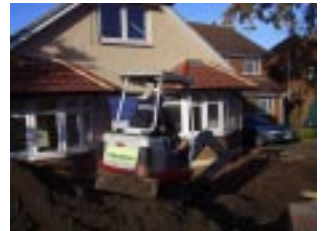
The dig out
